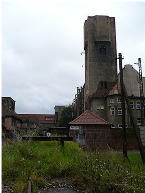
Budynki dawnej elektrowni kolejowej w Ścinawce Średniej w 2010 r. (źródło: Wikipedia.de)
